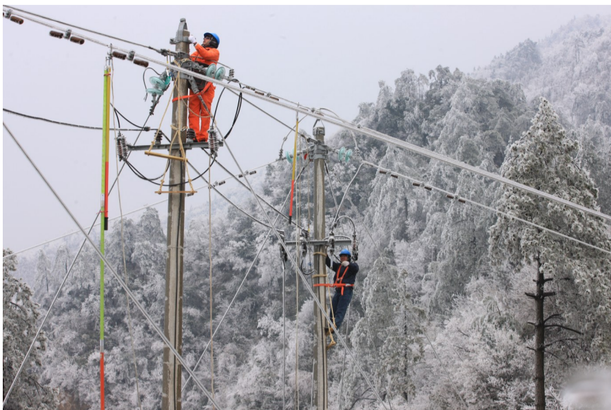
线作业面突击小组组长吴刚告诉笔者。据了解，为了不耽误狮石全乡群众用电，黄山、歙县两级供电公司的临时发电机组1月31日下午已经启动运行，暂时解决全乡群众的用电问题。因为供电人员施工抢修现场。·凌道文 文/摄·
