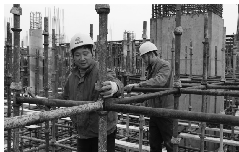
2月14日,来自徽州西递镇的农民土方蒋良和工友们正在黄山北站站场施工搭建脚手架,现场一片繁忙景象。据悉,黄山北站计划总投资5.49亿元,其中今年计划投资4亿元。
