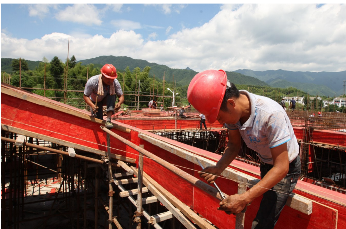
7月23日,黟县宏村景区旅游配套服务改造提升项目工程——宏村印象施工人员在搭建建筑模板。
