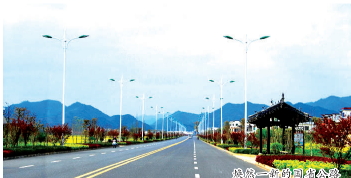
焕然一新的国道公路
